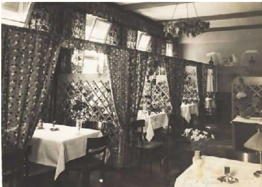
Ehem. Rest. Heurigenstüblerl (Georg Dormayr), 8001 Zürich (i.J. 1928)
